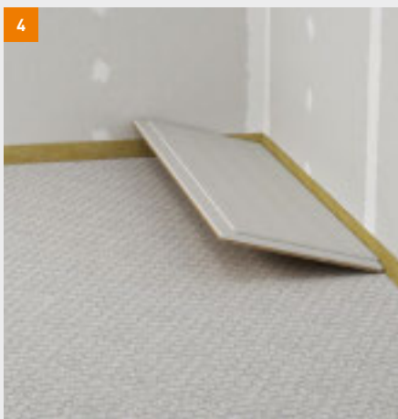
fermacell Estrich-Elemente verlegen
