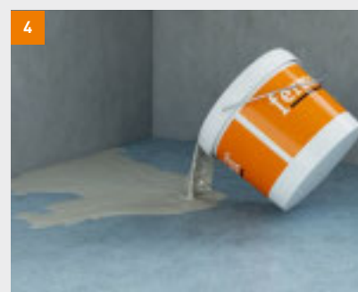
Boden-Nivelliermasse ausbringen und planeben nivellieren
