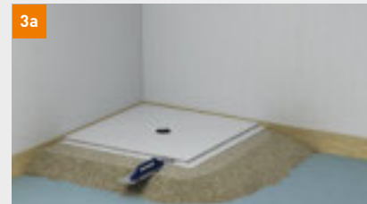
Variante A: Um das Duschelement wird in Höhe des überstehenden Falzes ein ca. 200 mm breiter Damm geschüttet – als Auflage für das Abziehen der restlichen Fläche
