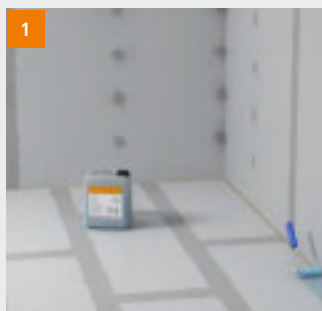
1 fermacell Tiefengrund im angrenzenden Wandbereich ...
