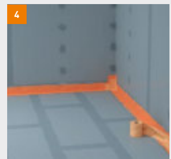
4 In die feuchte Flüssigfolie das fermacell Dichtband eindrücken
