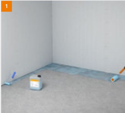
1 Grundierung des Untergrundes mit fermacell Tiefengrund
