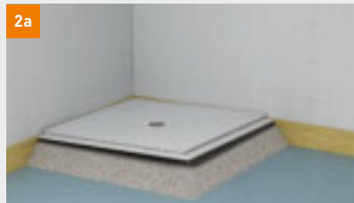
Variante A: In der Höhe der Oberkante des Ablaufgehäuses wird im Bereich des Duschelements die gebundene Schüttung abgezogen und das Duschelement gesetzt
