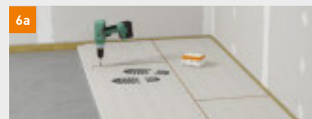
3 Verlegen der fermacell Estrich-Elemente
