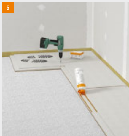
Verlegen der fermacell Estrich-Elemente auf fermacell Ausgleichsschüttung
