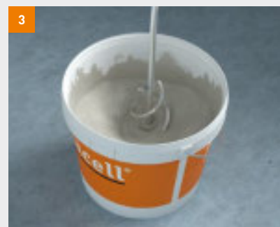
Mit geeignetem Rührgerät bei langsamer Drehzahl anmischen, bis eine homogene, klumpenfreie Nivelliermasse entsteht
