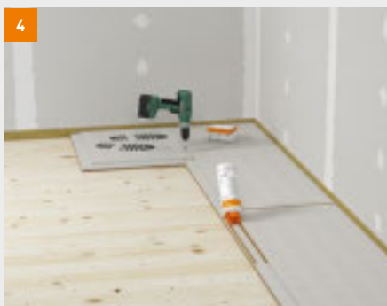
4 Auftragen des fermacell Estrich-Klebers im Falzbereich
