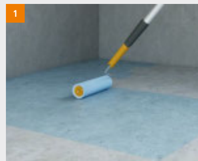
Vorbereitung: Boden grundieren
