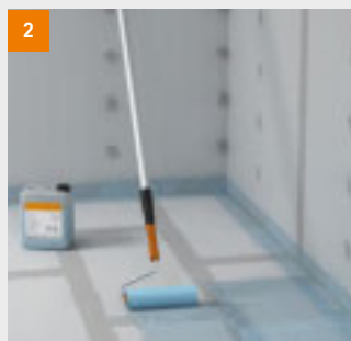
2 ... und Bodenbereich per Rolle auftragen
