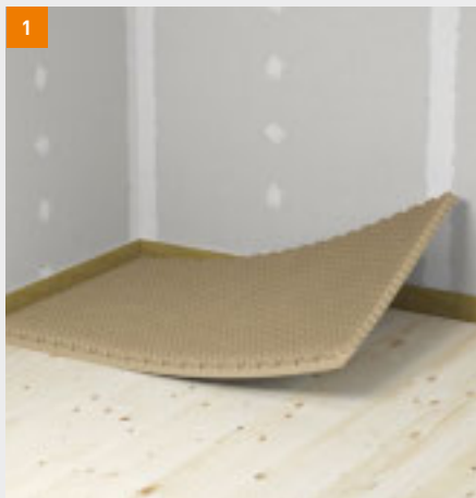
1 fermacell Estrich-Wabe verlegen
