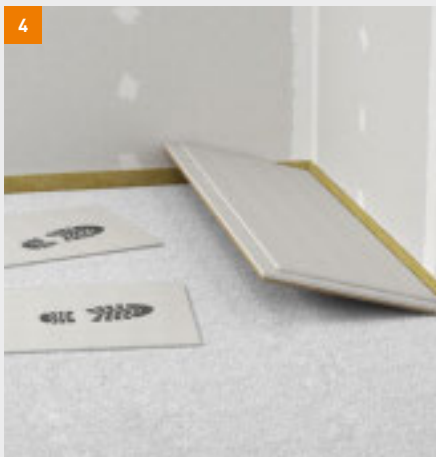
Verlegen der fermacell Estrich-Elemente auf fermacell Ausgleichsschüttung
