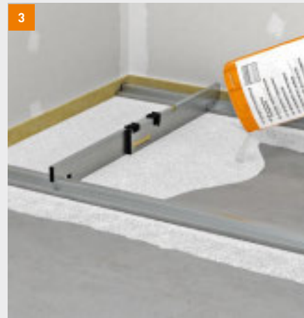
fermacell Ausgleichsschüttung einbringen
