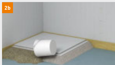
Variante B: Man zieht in Höhe der Oberkante des Ablaufgehäuses die gesamte Fläche mit der gebundenen Schüttung ab und setzt das Duschelement
