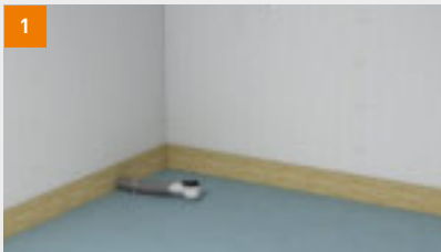
1 Nachdem die Lage des Duschelements markiert ist, wird das Ablaufgehäuse gesetzt
