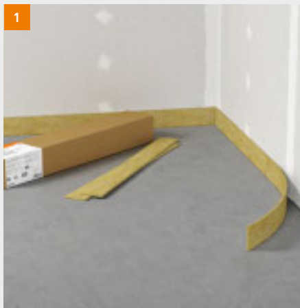
Anbringen der Randdämmstreifen
